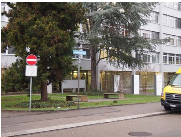
EDUCA-Gebäude auf der linken Strassen- seite.
